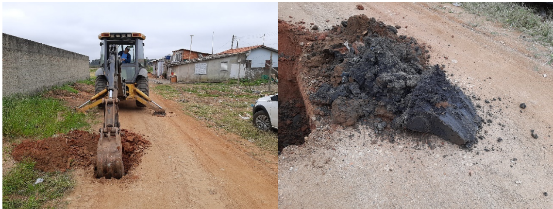
Figuras 5 e 6 – Furo de sondagem R. Manoel T. de Souza
