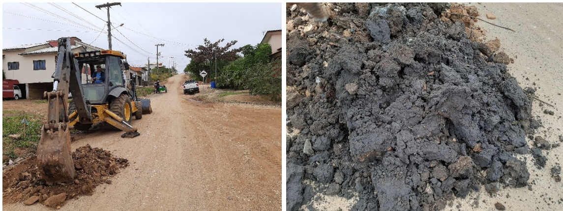
Figuras 13 e 14 – Furo de sondagem 02 R. São Tomé
