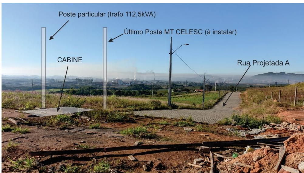
Imagem 2: Detalhe do local da subestação e ponto de entrega
